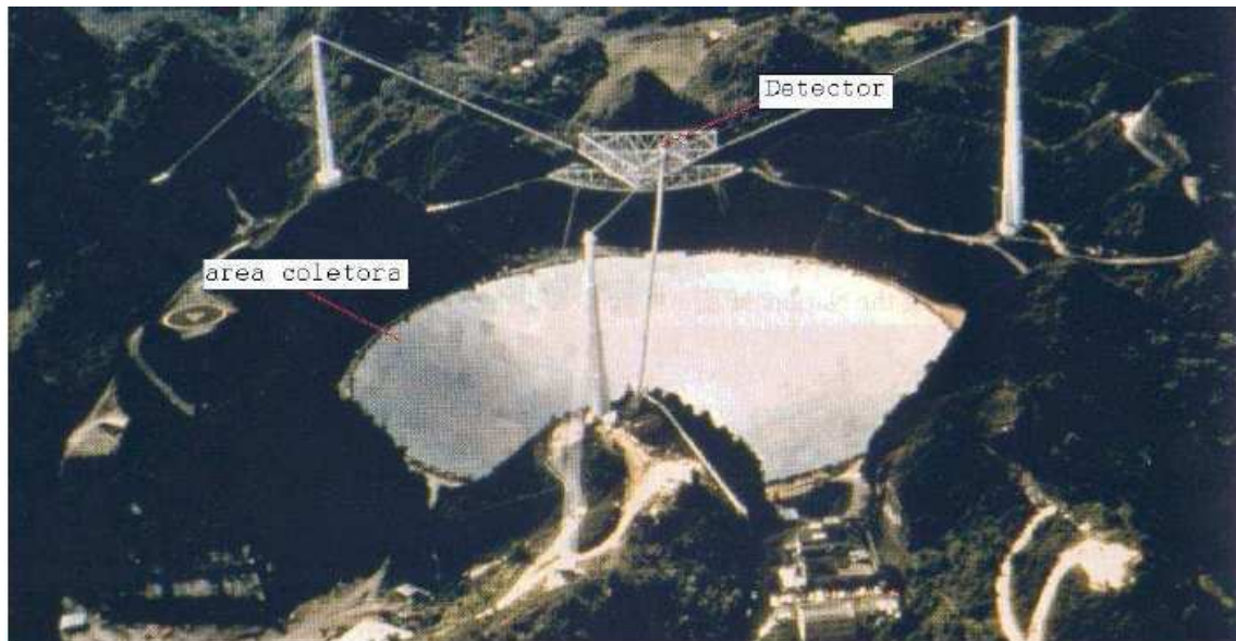
Figura 9: Radiotelescópio Arecibo, com 305 m de diâmetro, localizado em Porto Rico.
